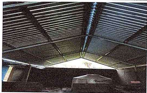
Foto1: Techo colocado vista desde adentro
